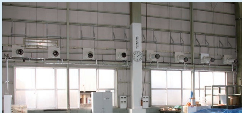
スポット・ゾーン空調システム「フレックスエア」を8台導入 ▲
