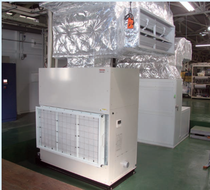
▲パッケージエアコン(左手前)と給気装置(右奥)
