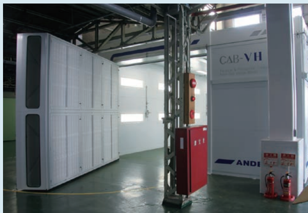
▲側面大扉開口の様子
