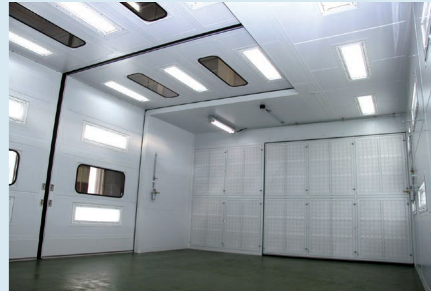
▲塗装ブース内給気側
